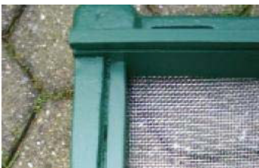
Detailaufnahme: Vierte Leiste ist schmaler, kürzer und ohne Nut.
