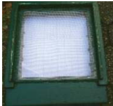
Detailaufnahme: Eck- Einleimung von unten betrachtet.
